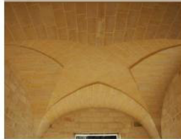
Figura 3.29: Volta a Spigolo o a "Stella".
