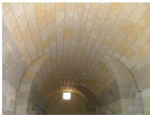
Figura 3.27: Esempio di Volta a Botte.
