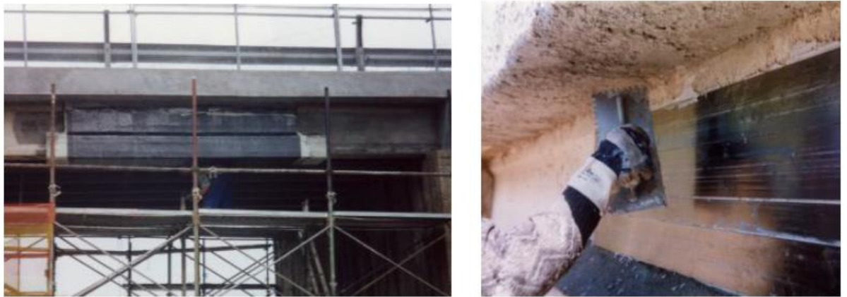
Figura 1.5: Ripristino del ponte Miglionico (Ancona).
